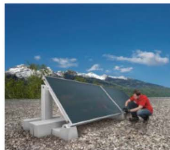
Hoval_Solarkollektor_UltraSol-2_Bild 2_Flachdach Betonsockel mit Techniker_(c) Hoval.jpg
