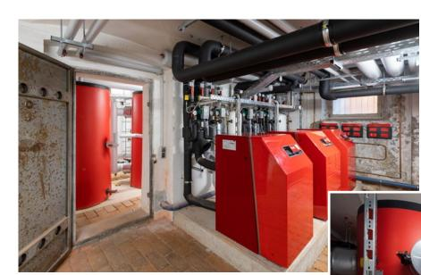
Die neue Heizzentrale besteht aus einem Gasbrennwertkessel UltraGas®, drei Wärmepumpen Thermalia® und einem Blockheizkraftwerk (BHKW).
