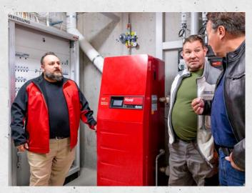
Ein Gasbrennwertkessel UltraGas® 50 in Kombination mit einem Warmwassererwärmer ESSR 100 beheizt die 1 500 m² Wohnfläche.
