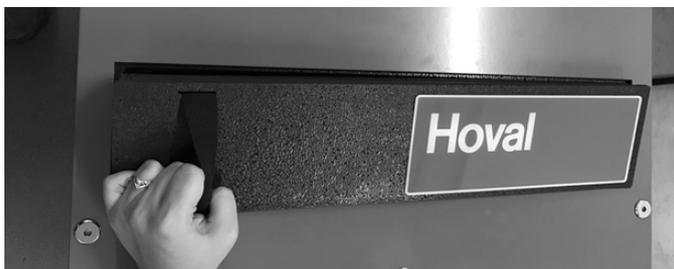
3. Filterhalterung durch eine 90° Drehung entfernen (sofern vorhanden)
